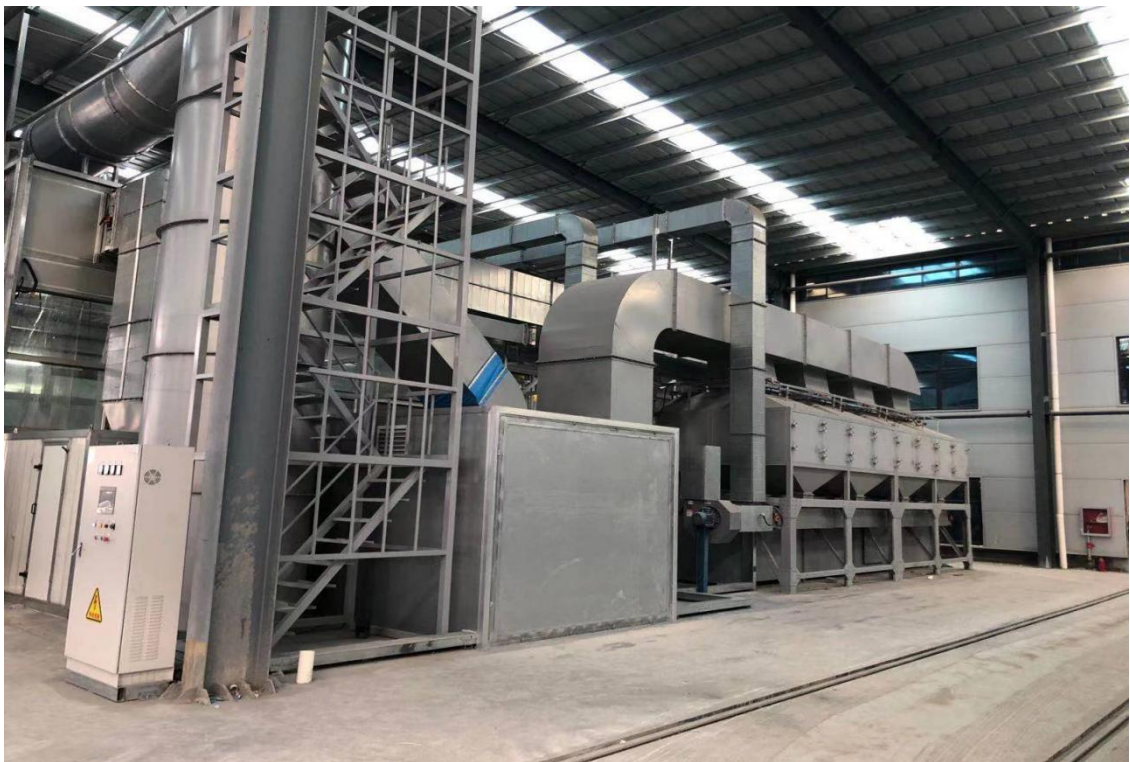
新建喷涂车间
